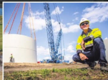
◀▲ Een kraan takelt de elementen op elkaar. Inzetje: constructie manager Hans van Belzen. FOTO'S GPHOTO
