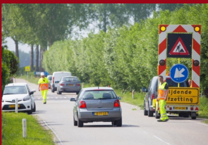
▲ Werkzaamheden aan de Korteweg worden afgerond, maar toch moet er nog worden gekeken naar een vrijliggend fietspad. © Qphoto
