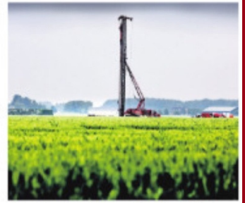
▲ De heiwerkzaamheden zijn begonnen. FOTO VICTOR VAN BREUKELLEN
