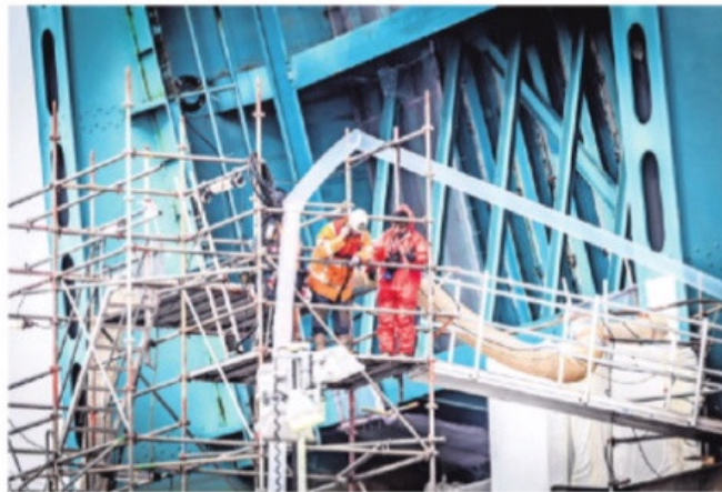
▲ De reparatiewerkzaamheden afgelopen weekend draaiden om het verstevigen van de hoofdliggers.
