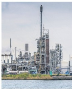
▲ Chemours legt zich niet neer bij de aanscherping van de vergunning door de provincie.
