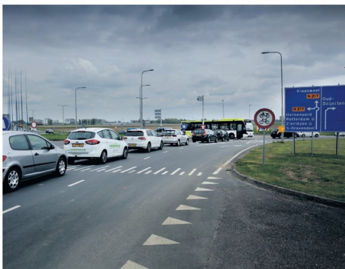
◀ De rotonde bij het Oud-Beijerland bedrijventerrein wordt uitgebreid, zodat auto's vanaf de Jan van der Heijdenstraat straks minder lang in de file staan. FOTO: VICTOR VAN BREUKELLEN
